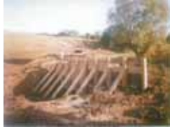
V. Deversorul finalizat
